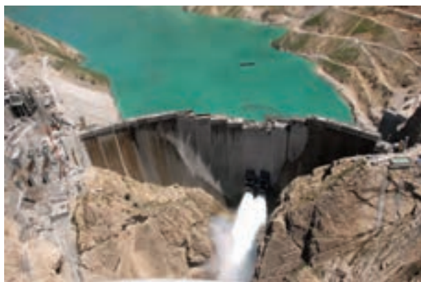
شکل ۶- سد کارون ۴ - خوزستان
